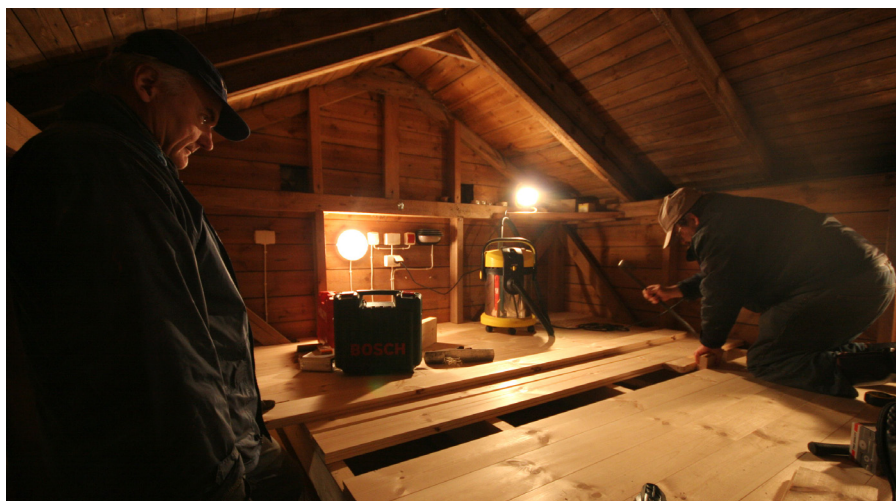
Kevolan viimekesäinen talkookausi päättyi lokakuussa Zeniittitornin yläkerran lattian uusimiseen. Talkoot jatkuvat jälleen ensi kesänä. Kuva: Juhana Ahlamo
