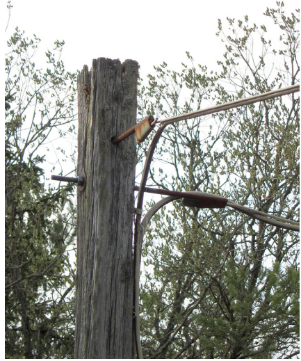
Rakennusten väliset sähkökaapelit tullaan uusimaan ja muuttamaan maakaapeleiksi vuoden 2012 aikana. Kuvat: Juhana Ahlamo
