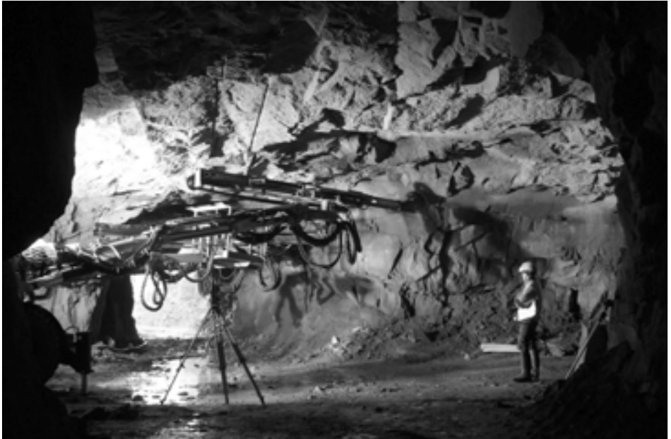
Aulan poraus käynnissä.
