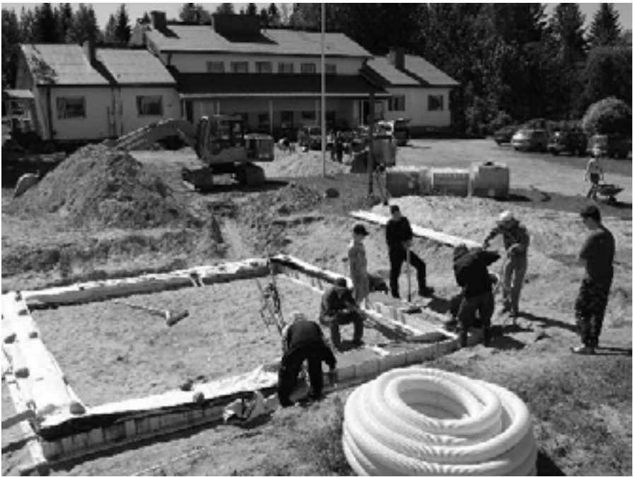
Tähtitornin perustuksen anturan tekoa. Kuva Arto Oksanen
