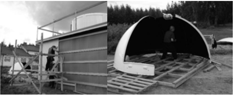
Tähtitornin seinien panelointia ja kuvun kasausta. Kuvat Arto Oksanen
