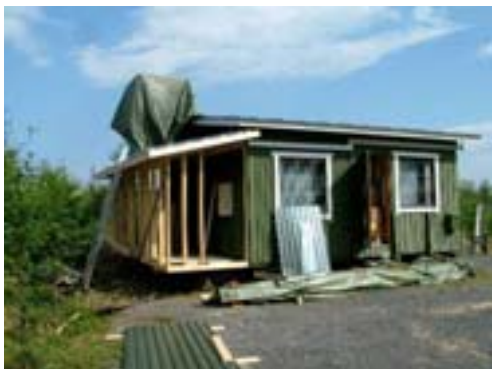
Revontulikameran suojatorni rakenteilla Nyrölässä
