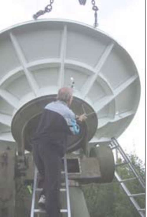
Teleskoopin osat nostetaan paikoilleen
