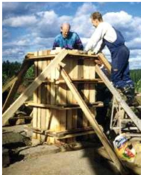
Antti Maukosen tekemää valumuottia pystyttämässä Jalo Ojanperä ja Riku Pitkänen.
