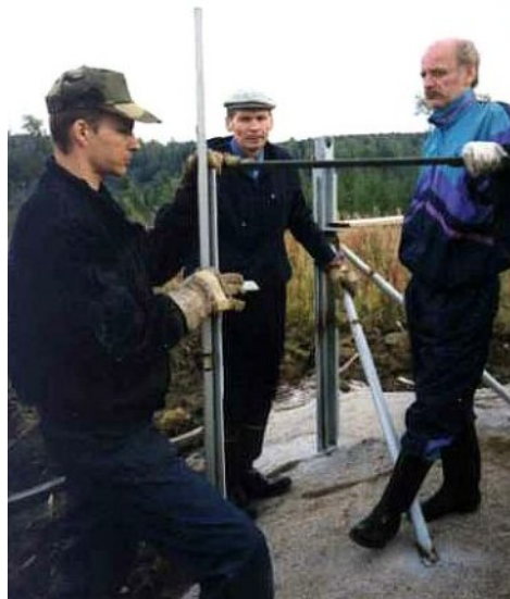
Kallio on kuorittu paljaaksi ja runkotolppien paikkoja mitataan. Kuvassa keskellä Siriuksen pitkäaikainen aktiivijäsen, jo edesmennyt Aimo Nikander.
