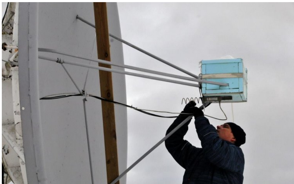
Vastaanottimen asennus menossa Murtoisissa.
