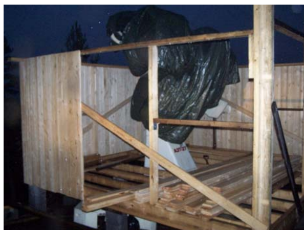
Keski-Uudenmaan Altair rakentaa tähtitornia 50 cm teleskoopille. Kuvat Seppo Linnaluoto.
