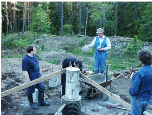
Kaukoputken jalusta valettu. Kuvassa vasemmalta Antti Kuosmanen, Ville Marttila, Erkki Karumaa ja Kaj Wikstedt.
