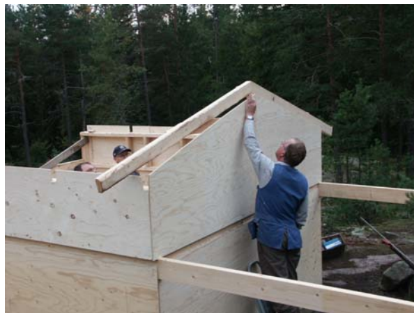
Syyskuussa Erkki Karumaa rakentaa katon päätä.
