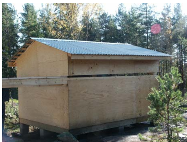
Liikkuva katonosa nousemassa rullille lokakuussa.
