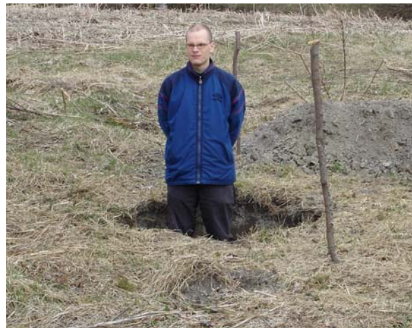
Pylvästä varten kaivoin kuopan hiekkakerrokseen saakka.
