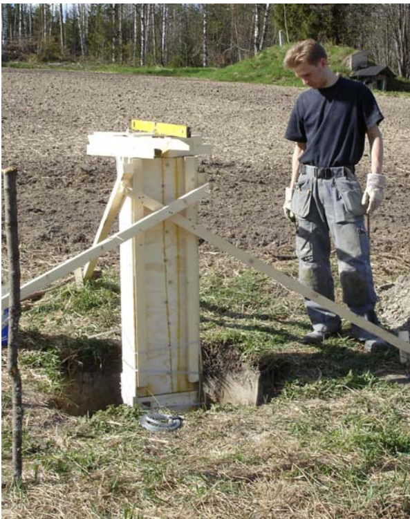
Valutyö on tehty. Pylväs seisoo betonikakun päällä. Valumestarina oli Vesa Marttila.
