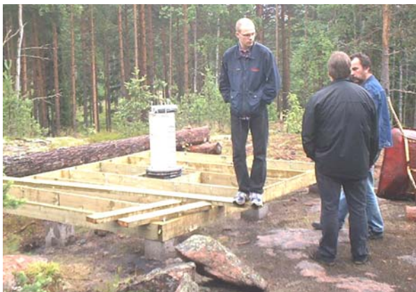
Putken jalka on valettu ja pohjakehikko valmiina. Tornin päällä Ville Marttila, oikealta Kaj Wikstedt ja Mikko Mannonen selin. Kuva S. Linnaluoto.
