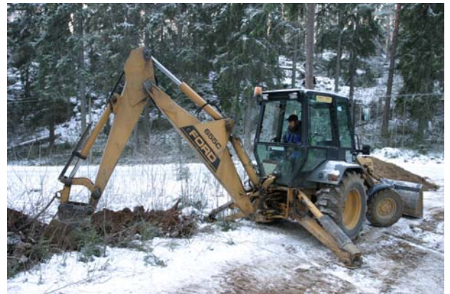
Kaapeliojan kaivaminen käynnissä. Kuva Hannu Hongisto.
