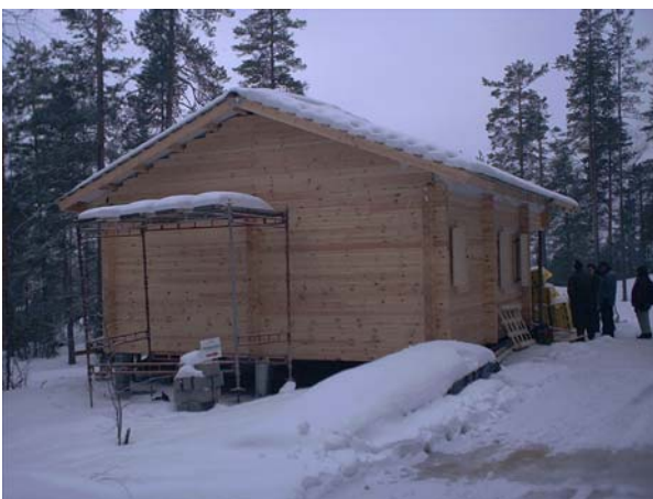
Ohjausrakennus on melko valmiina. Kuva Seppo Linnaluoto.
