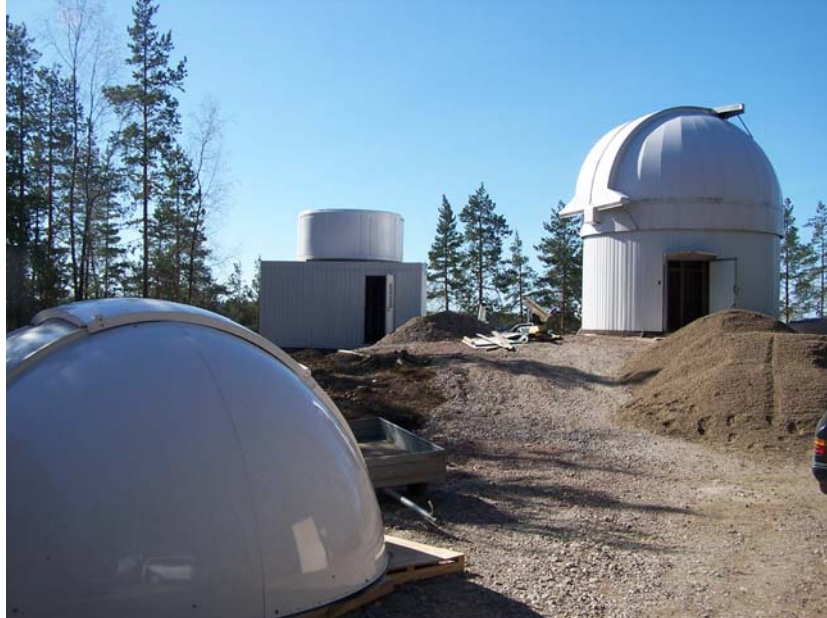
Artjärven uusi tähtitorni oli kohoamassa hyvää vauhtia vanhan viereen. Ursan vanha 42 cm kaukoputki on tarkoitus sijoittaa siihen ja vanhaan tähtitorniin pannaan uusi lähes metrinen kaukoputki. Uuden tähtitornin kupoli on vielä maassa. Nytemmin se on kohotettu tornin päälle. Kuva Seppo Linnaluoto.
