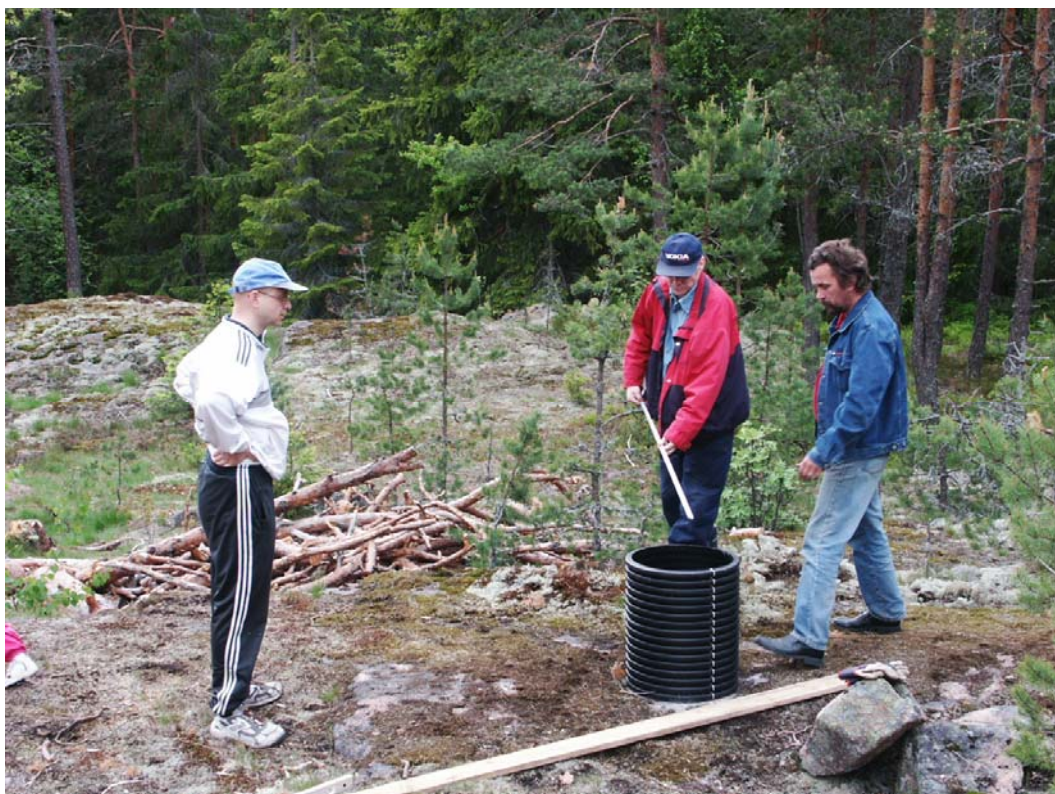
Kesäkuussa vuonna 2004 valmisteltiin kaukoputken jalustan valua.
