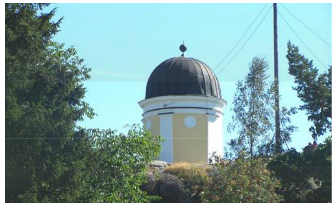
Ursan torni Helsingin Kaivopuistossa. Kuva Seppo Linnaluoto.
