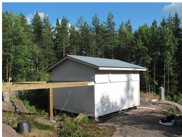
Kesän 2015 remontti. Kaukoputkisuoja on juuri saanut pintaansa uuden pohjamaalin. Kuva Hannu Hongisto.
