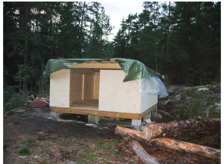
Ensimmäisen vaiheen rakennustyöt tehtiin syksyllä 2004. Kuva Hannu Hongisto.
