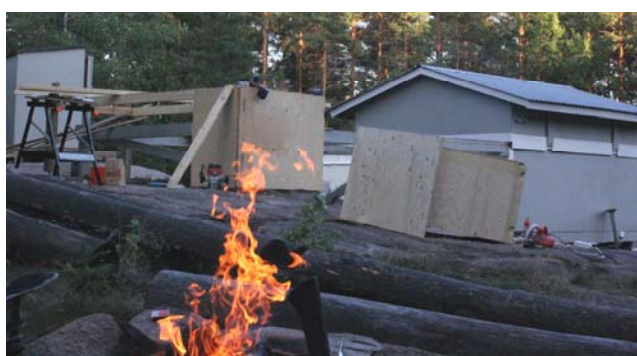
Torni rakennusvaiheessa. Kuva on otettu nuotiotulen suunnasta, jonne liiat neuvojat opastettiin. Kuva Antti Kuntsi.
