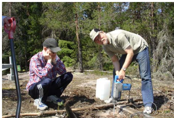
Kesäkuussa porattiin tornin jalustoille reikiä. Kuvassa vasemmalla on Ville Marttila, oikealla Hannu Hongisto.
