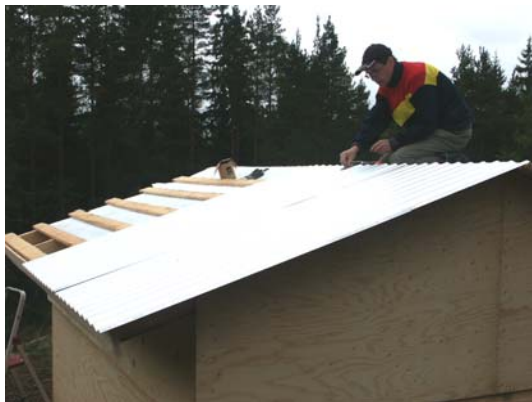
Heikki Marttila Komakallion tornin kattolevyjä asentamassa.
