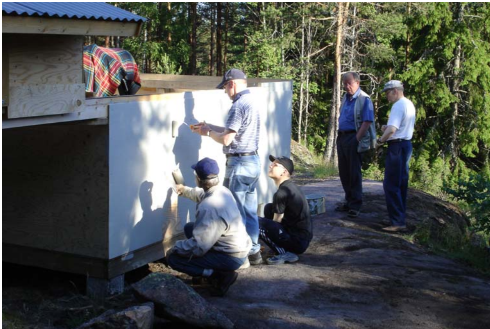
Kesäkuussa Komakallion torni sai maalipinnan. Kuva maalaustalkoista.
