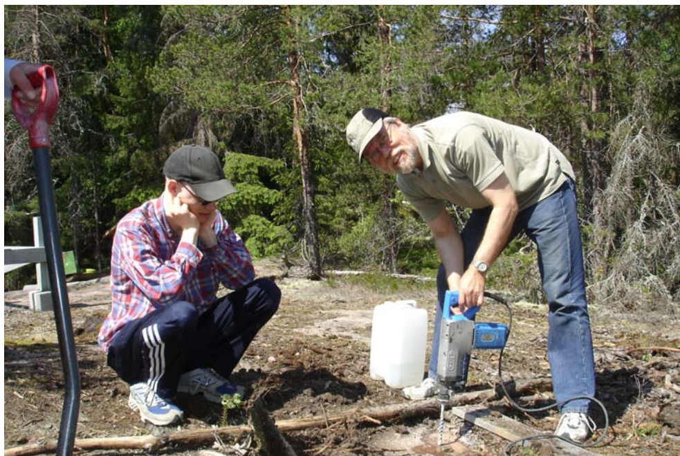
Komakalliolla uuden havaintokopin työt ovat aloitettu. Kuvassa porataan reikiä anturoille.
