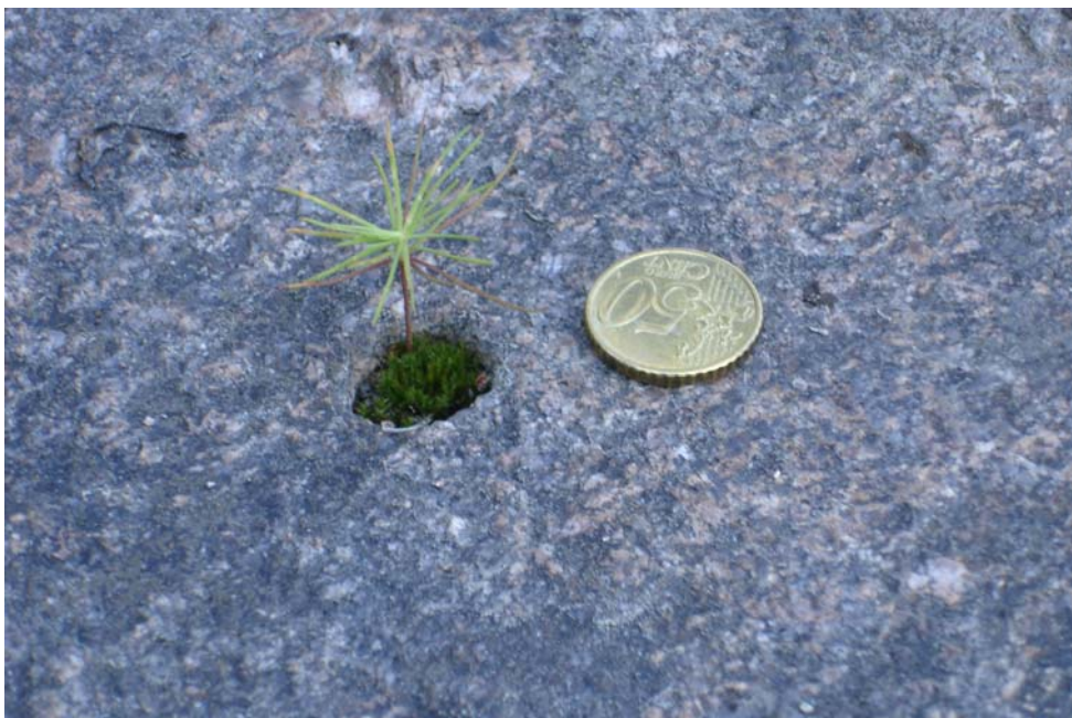
Puuntaimi kasvaa Komakalliolla tornin rakentamisen aikana tehdyssä porareissä.
