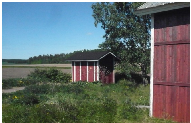
Kuva 12: Makasiinin takana oleva vesiklosetti
