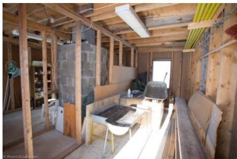
Laitetila ennen rakennustöitä. Kuva: Harri Kiiskinen
