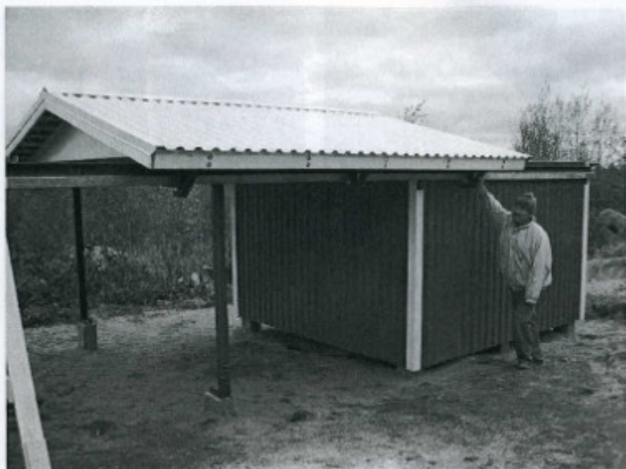
Katto liikkuu kaukoputken päältä helposti työntämällä kiskojen varassa.
