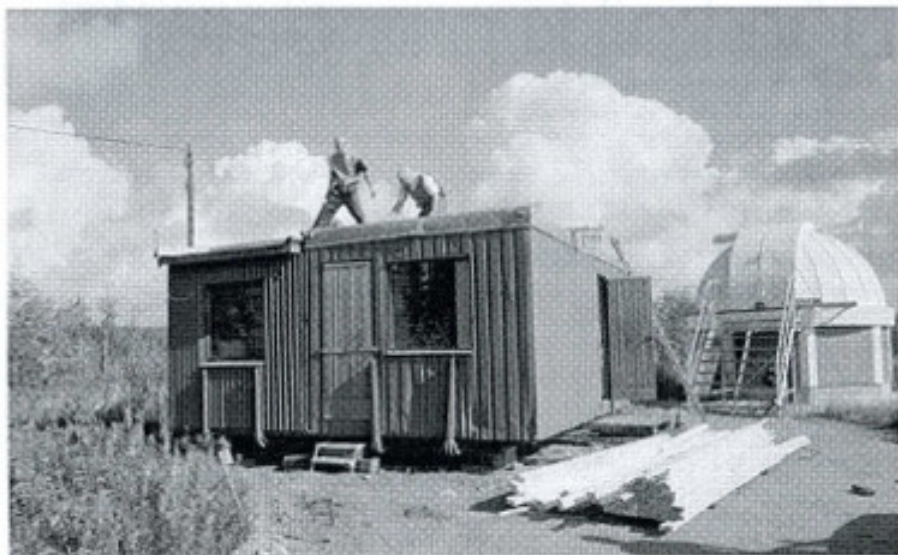
Nyrölään observatorion uusi huoltorakennus asennettiin vanhemman viereen kesän 2001 aikana ja samalla rakennettiin molempia rakennuksia suojaava yhteiskatto. Kuvassa katon rakentaminen on juuri alkanut. Kuva Arto Oksanen.
