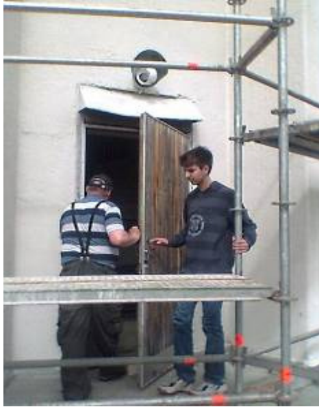
Sisäänpääsy oli jo rakennustelineiden takana
